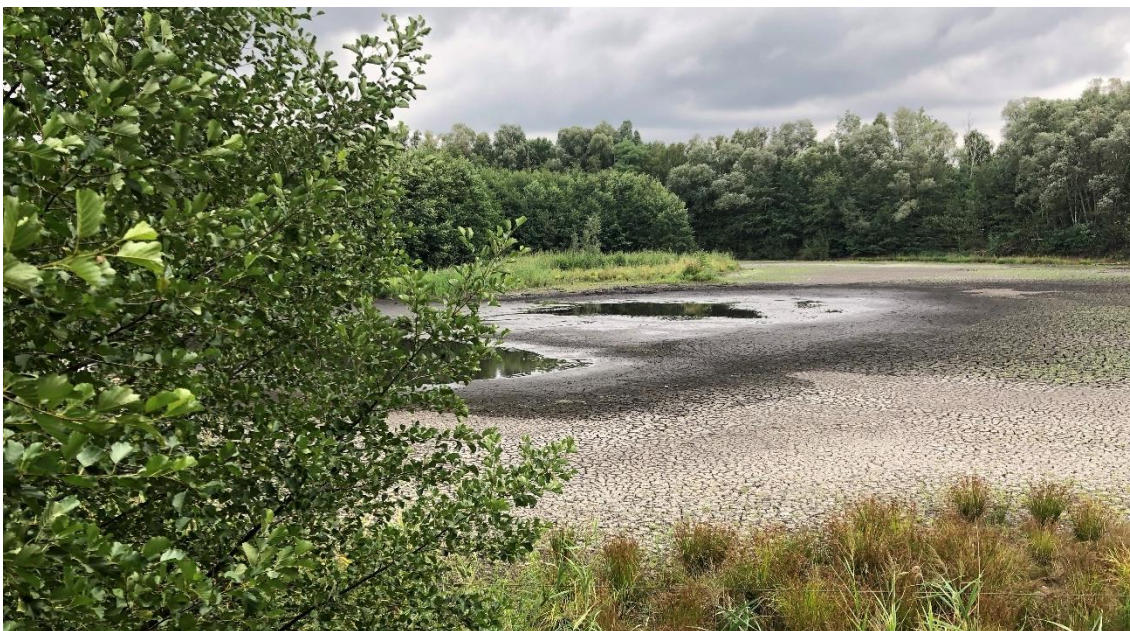
Abb.9: trockengefallenes Schlammauflandebecken nach Inbetriebnahme Sickerbecken Kaufland (Datum der Aufnahme: 23.08.2022; Quelle: Stadt Lübbenau/Spreewald)
