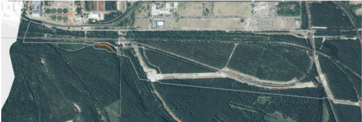
Abb. 22: Flächeninanspruchnahme – Schutzfunktion „Bodenschutzwald nach Sächsischem Waldgesetz“ (Quelle: Geoportal Sachsen)
