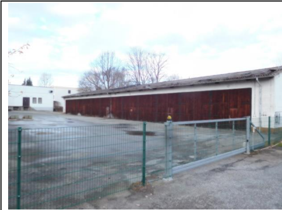
Abb.: 12: westlicher Garagenkomplex (eigene Aufnahme)
