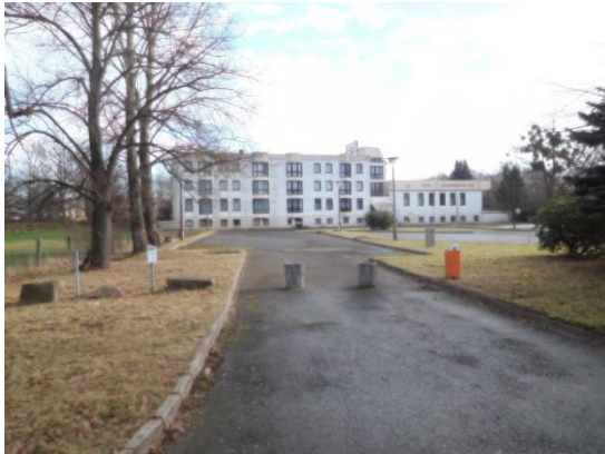
Abb.: 2: ehemaliges Hotel „Reichenbacher Hof“ (eigene Aufnahme)
