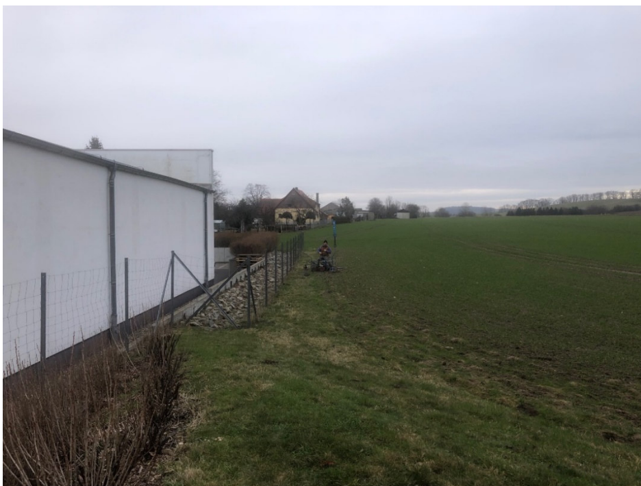
Bild 2 (2024): Erweiterungsfläche, Blickrichtung Süden, vorn Wiese, hinten Aufschluss RKS 22 (2024), links Westachse des Bestandes
