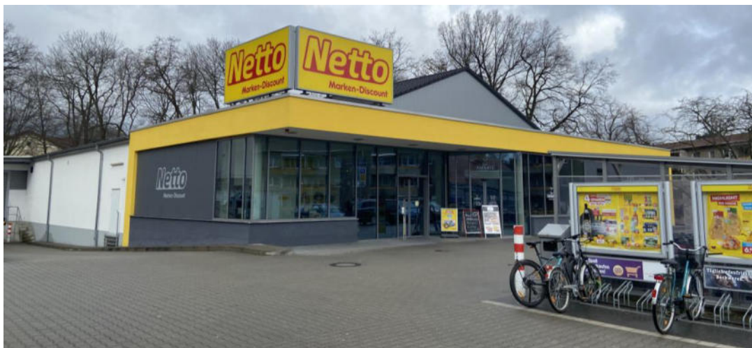
Abbildung 15: Netto-Lebensmitteldiscounter an der Berliner Chaussee 18 in Bad Muskau (NVL Berliner Chaussee)
