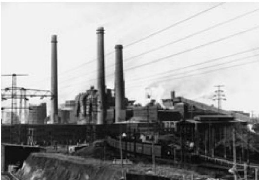
Abbildung 3: Außenansicht des Kraftwerkes Böhlen (IKW Böhlen) in den fünfziger Jahren
