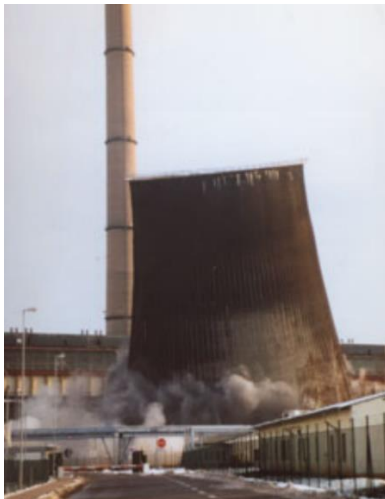
Abbildung 6: Sprengung des ersten Kühlturmes am Altkraftwerk Lippendorf am 06.12.1997. Der zweite Kühlturm wurde 2005 rückgebaut /13/
