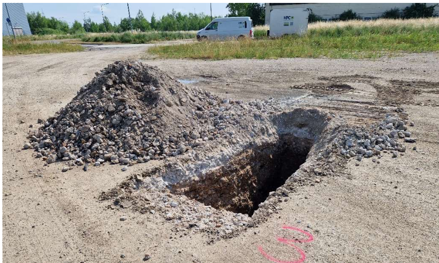
Abb. 6: Haufwerk neben Baggerschurf 3
