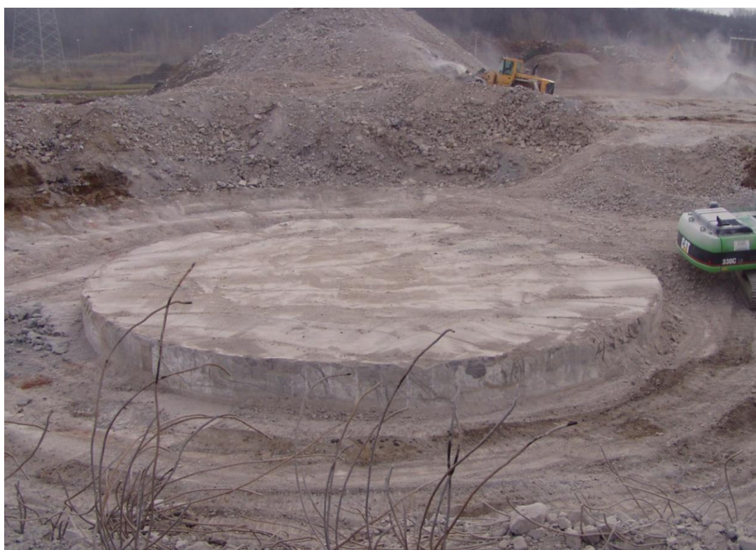
Abbildung 2: Abbruchdokumentation Schornsteinfundament
