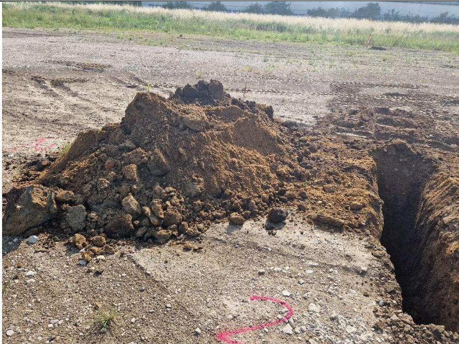
Abb. 4: Haufwerk neben Baggerschurf 2
