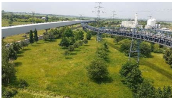
Foto 10: Abstandsfläche NW-Ecke, Code: 11.03.900, rechts mit Förderbandanlage, Code: 11.02.400
